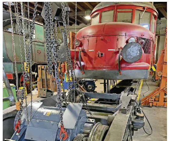
Der «Rote Pfeil» beim Einbau der Elektromotoren.
