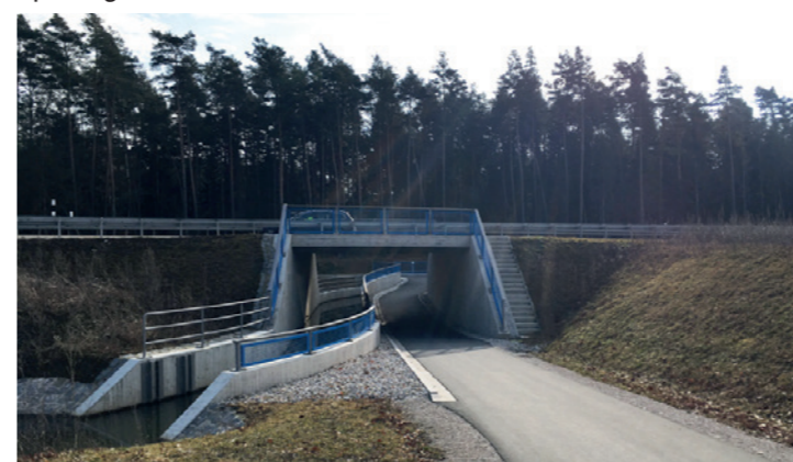
Referenz: Unterführung mit offengelegtem Bach/Kanal
