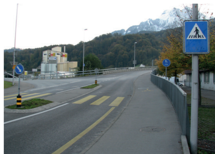
Brücke (Abschnitt 1) Richtung Technikumstrasse
