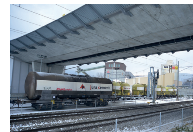
Blick vom Zentralbahntrasse unter der Kantonsstrasse
