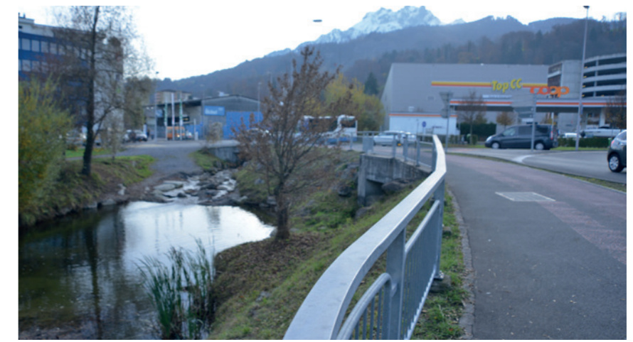
Bachraum südlich der Ringstrasse, Technikumstrasse
