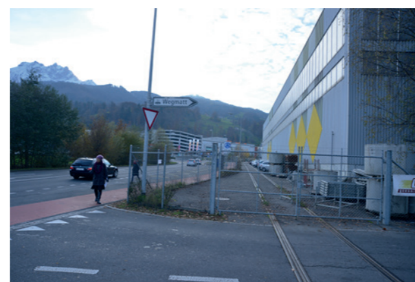
Industriegleis entlang der Ringstrasse
