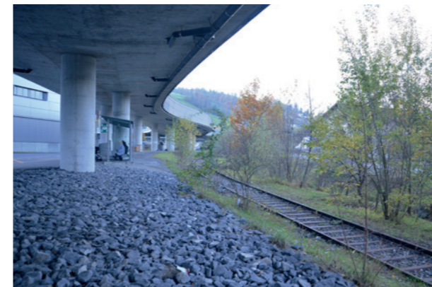
Industriegleis im Bachraum unter der Autobahnzufahrt
