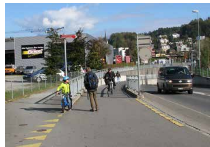
konfliktträchtige Unterführung Ringstrasse Horw: Fuss- und Veloverkehr auf engem Raum (Foto Team LuzernSüd)
