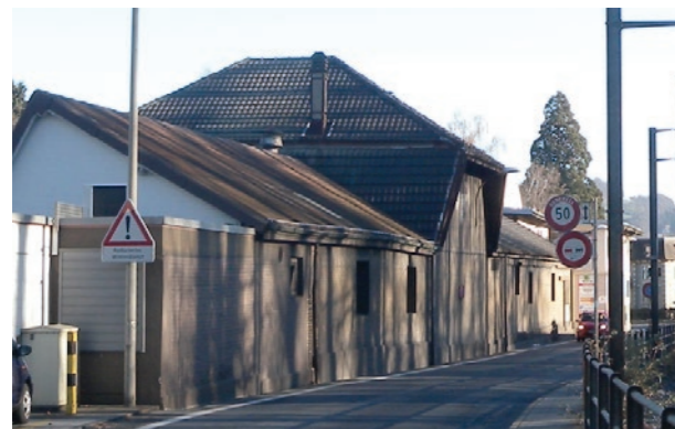
Arsenalstrasse (SüdAllee): Unattraktive Fusswege
