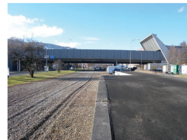
Kiesband zur Langsägestrasse Blick auf Autobahnbrücke A2
