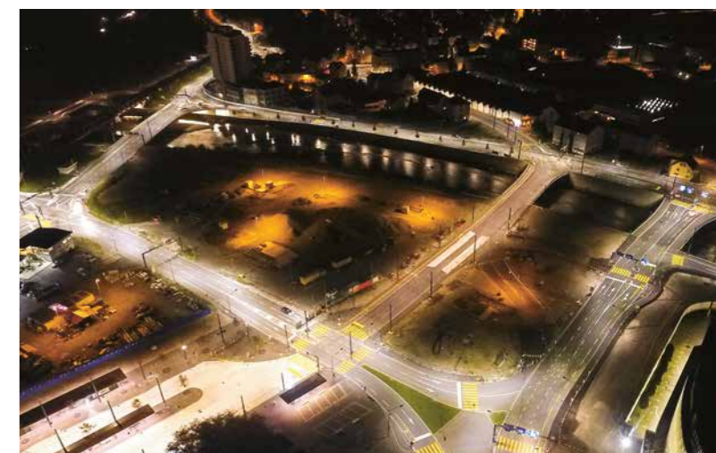
Die neue Verkehrsführung rund um den Seetalplatz bei Nacht (Foto Dienststelle vif)
