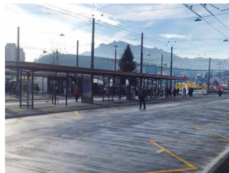
Der Bushub am Bahnhof in Emmenbrücke ist eröffnet mit den neuen RBus Linien 2 und 5.
