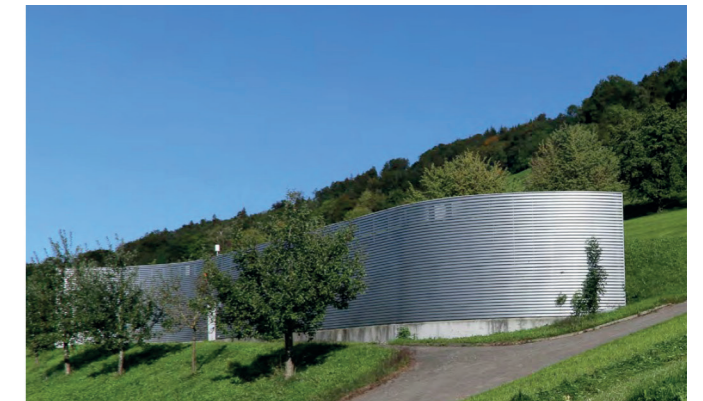
Grösstes Reservoir der Wasserversorgung Root (Brauchwasser: 1'175 m 3 ; Löschwasser: 350 m 3 )
