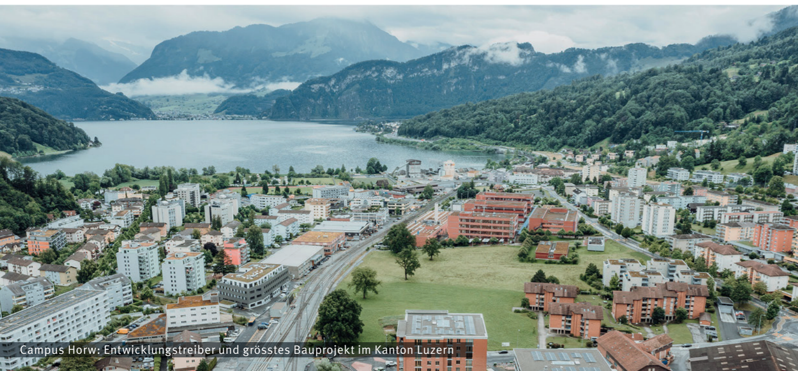
«neuRaum» in Horw: Eines der vielen Leuchtturmprojekte im Energiebereich
