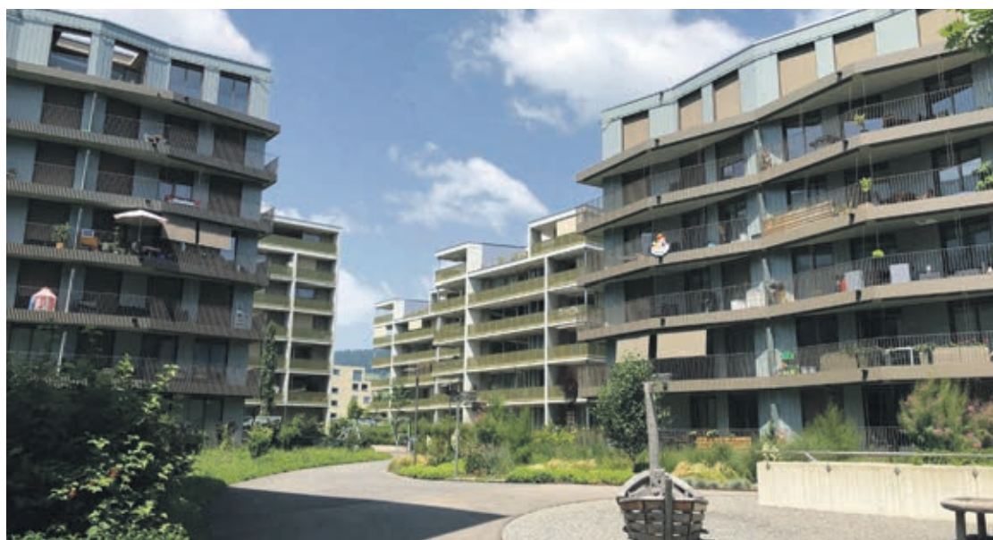
Der Schweighof ist das erste 2000-Watt-Areal der Zentralschweiz. Es wird zudem mit erneuerbarer Energie aus dem Vierwaldstättersee versorgt. Bild: PKG
