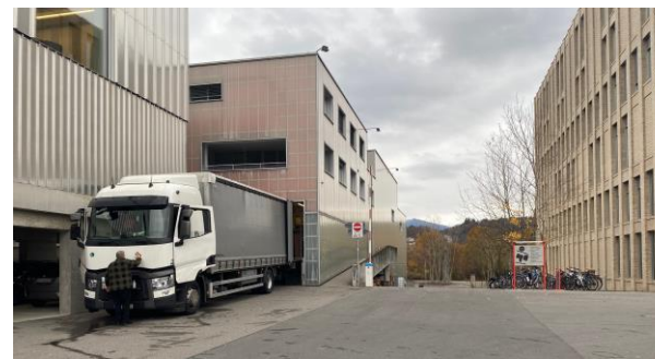
Beispiel Südpol Kriens: auch bei Industrie- und Logistikknutzungen sind Überlagerungen möglich (Bild vdw).
