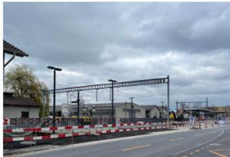
Umbau Rothenburg-Station (Bild Team)
